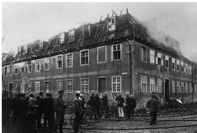
Der neben dem Stadtbrand von 1945 bisher schwerste Brand der Herrnhuter Geschichte zerstörte am 8. August 1921 das Witwenhaus sowie mehrere Gebäude an der Ladengasse, der heutigen Dürningerstraße (Inv. 5135).
