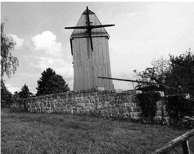
Sommer 2016, Fenster, Treppen und die äußeren Hüllen werden erneuert
