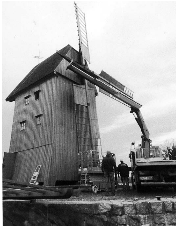
November 2016 – die Flügel werden montiert
