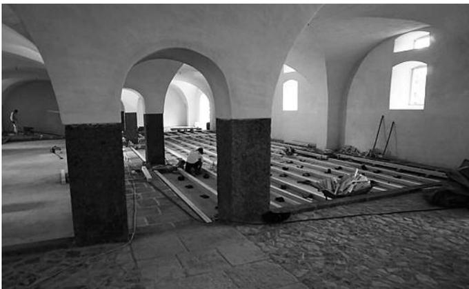
Ein neuer Fußbodenaufbau erfolgt im Kernbereich. Im Wandbereich und in der Mitte um den Gewölbegang werden Granitkrustenplatten verlegt. Der gesamte Innenraum wird neu verputzt (über 1 000 m<sup>2</sup>). Der Bereich für das Publikum wird mit Tannenholz gedeckt.
