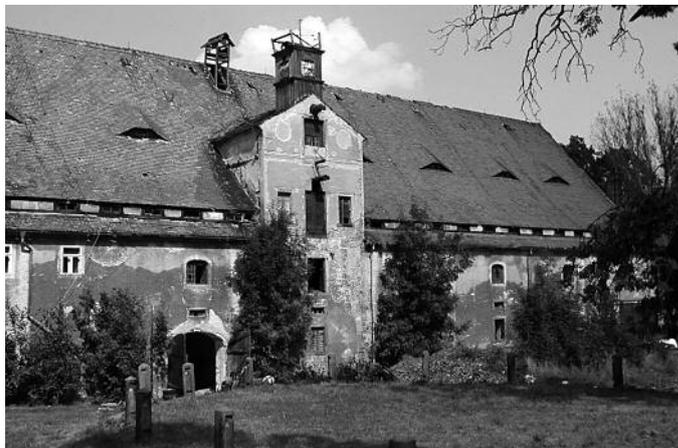
Diese Aufnahme aus dem Jahre 2002 zeigt den Zustand, in dem das Gebäude dem Freundeskreis von der Treuhand übertragen wurde. In den Jahren 2004 bis 2006 wurde das Dachtragwerk notgesichert und die Dachfläche mit historischen Ziegeln umgedeckt. So war der weitere Verfall abgewendet.
