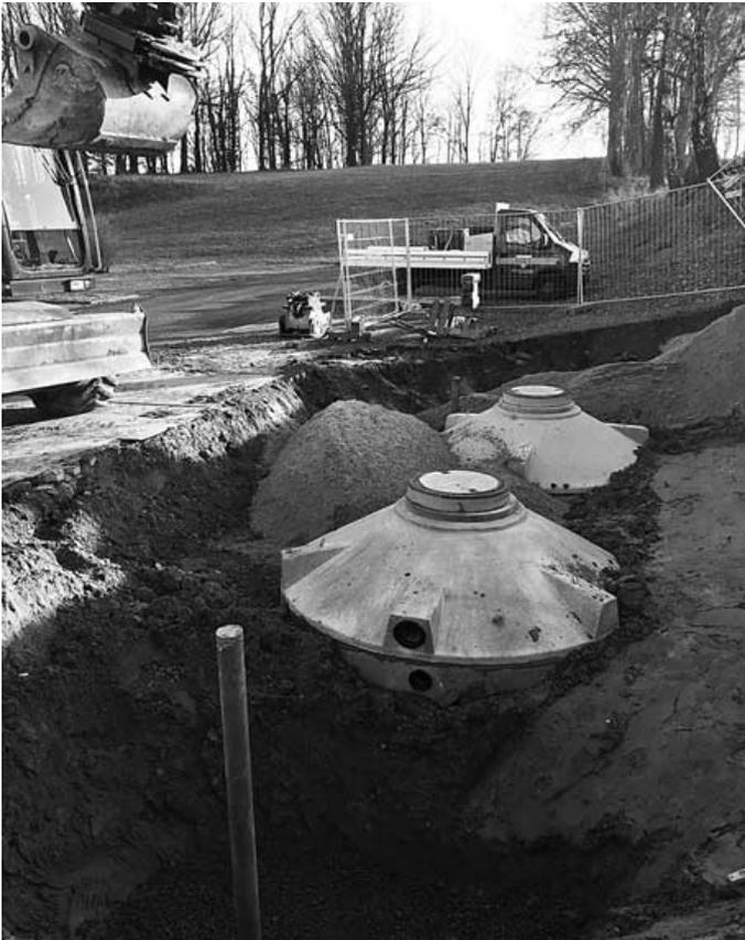
Die beiden Vorratsbehälter (Zisterne) sowie das Rohr des Tiefenbrunnens (vorn) während des Einbaus.
