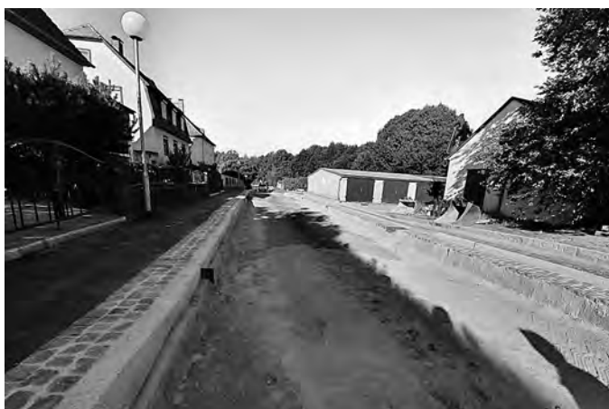
Vorbereitungen für den Asphaltbau im 3. BA, Borde und Pflasterzeiler sind gesetzt
