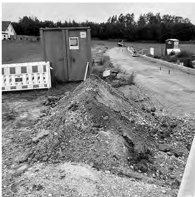
Vorbereitungen für den Asphaltbau im 3. BA, Borde und Pflasterzeiler sind gesetzt
