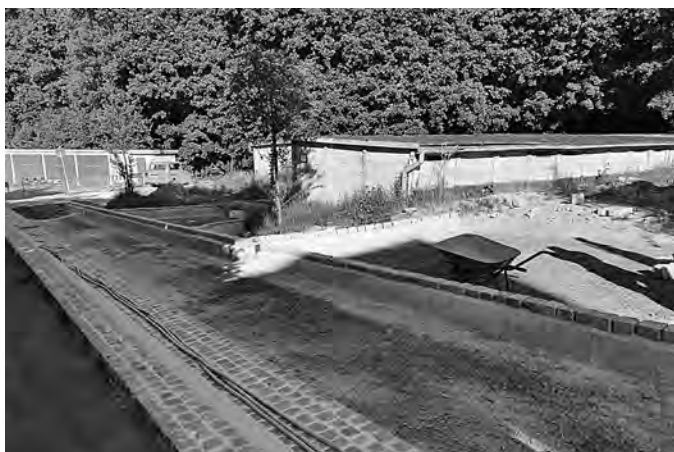
Angleichung der Zufahrten zu den Garagen
