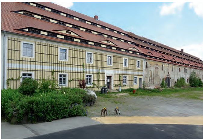
Ein Bild aus dem Jahr 2014, der westliche Teil (Wohnteil) wurde in den Jahren 2004–2006 saniert.
