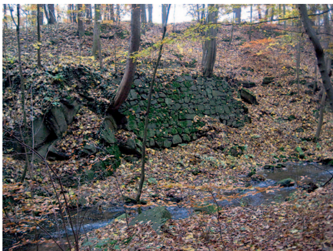
Alter Mühlgraben zur Schlossmühle oberhalb der Petersbach mit Bruchsteinmauer gestützt. Foto: Matthias Pfeifer
