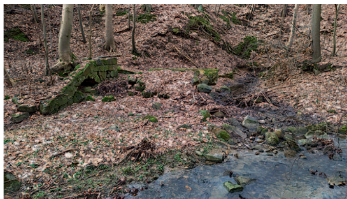
Reste des alten Wehres im Petersbach, an dem der Mühlgraben abzweigte. Foto: Matthias Pfeifer
