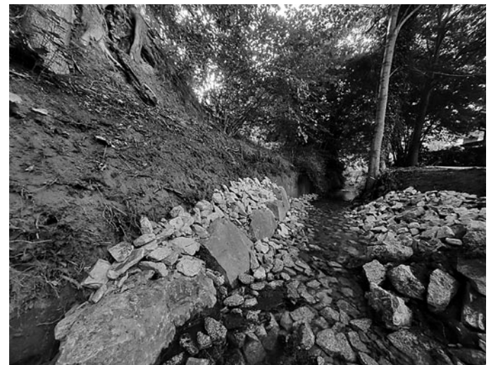
Herstellung des Steinsatzes im Anschluss an die vorhandene Stützwand
