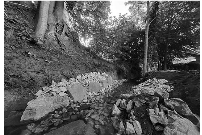
Herstellung des Steinsatzes im Anschluss an die vorhandene Stützwand
