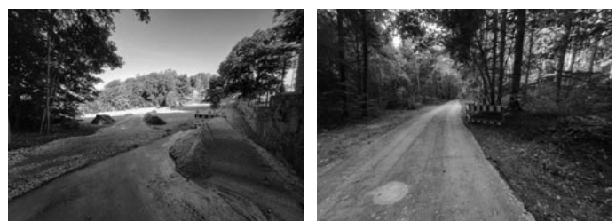
Baustraße aus Richtung Herrnhut
