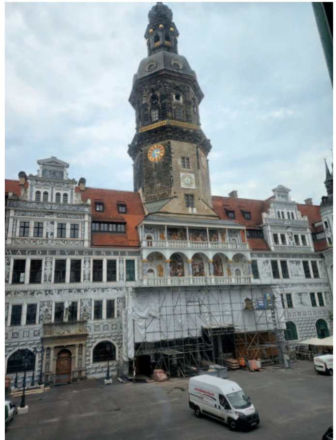
der große Schlosshof ist teilweise noch im Bau
