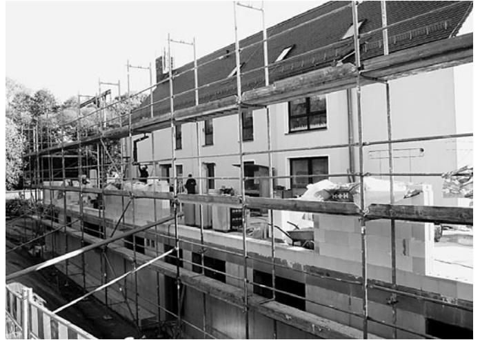
Decke über UG betoniert, Mauerarbeiten Erdgeschoss
