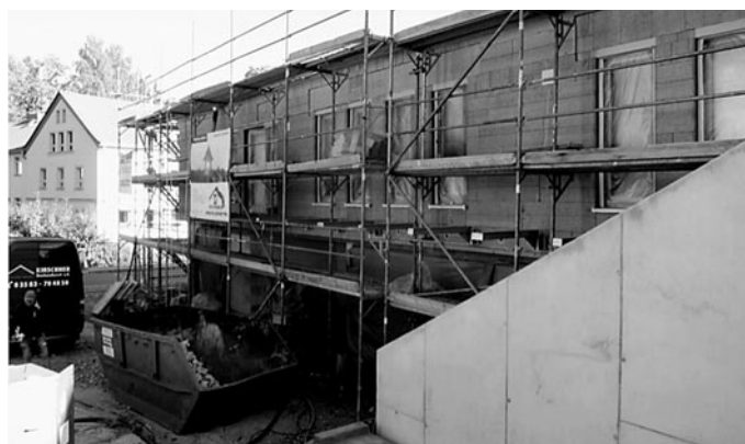
Einbau Wärmedämmung Fassade
