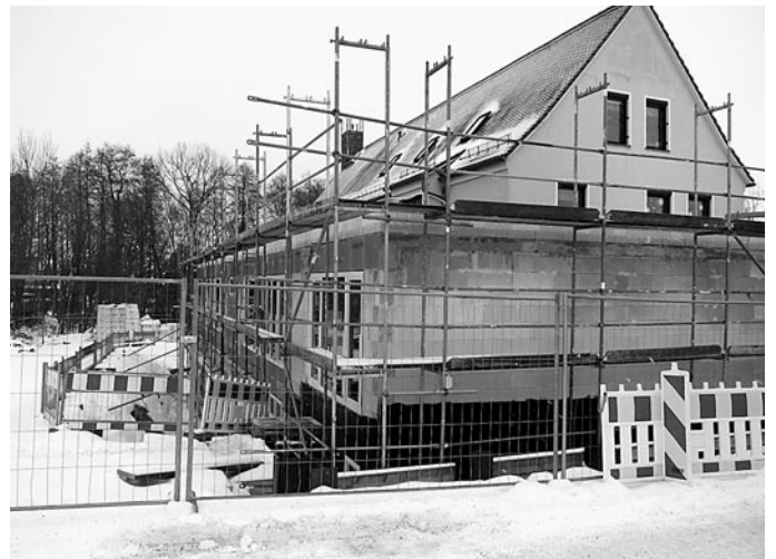
Fenster und obere Lage der Dachabdichtung eingebaut, Wintereinbruch
